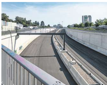
Blick auf den 16. Bauabschnitt der A100. Er soll 2025 eröffnen.
